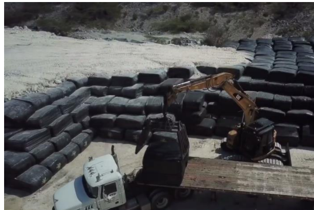
Sistema de disposición final de residuos enfardados
