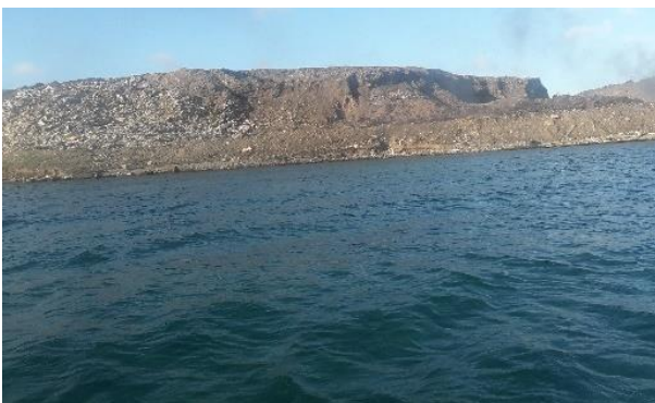
Vista del Vertedero de Parkietenbos (Oeste – Este ) desde el océano
